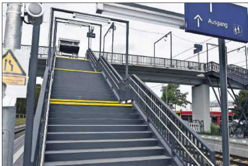
Zu den Bahnsteigen 2 und 3 und von dort aus in die Stadt kommt man nur über diese Treppe. Der Aufzug funktioniert noch immer nicht. FOTO: BOLTE
